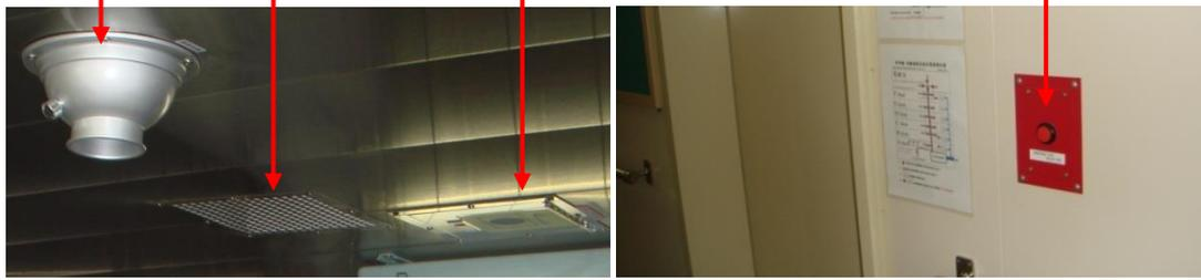
廚房冷氣 緊急切斷 Damper(手拉式)
